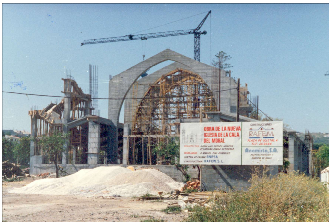
MAYO DE 1989- LA ESTRUCTURA DE ARCOS APUNTADOS TOMA CUERPO
