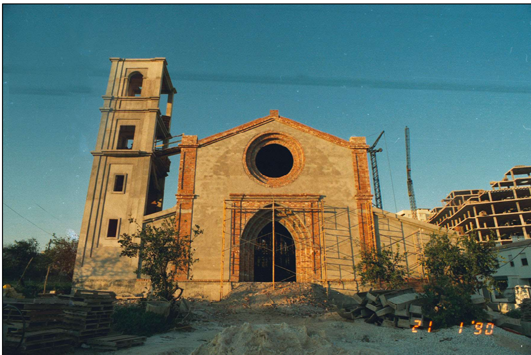
ENERO DE 1990- ESTADO DE LA FACHADA
