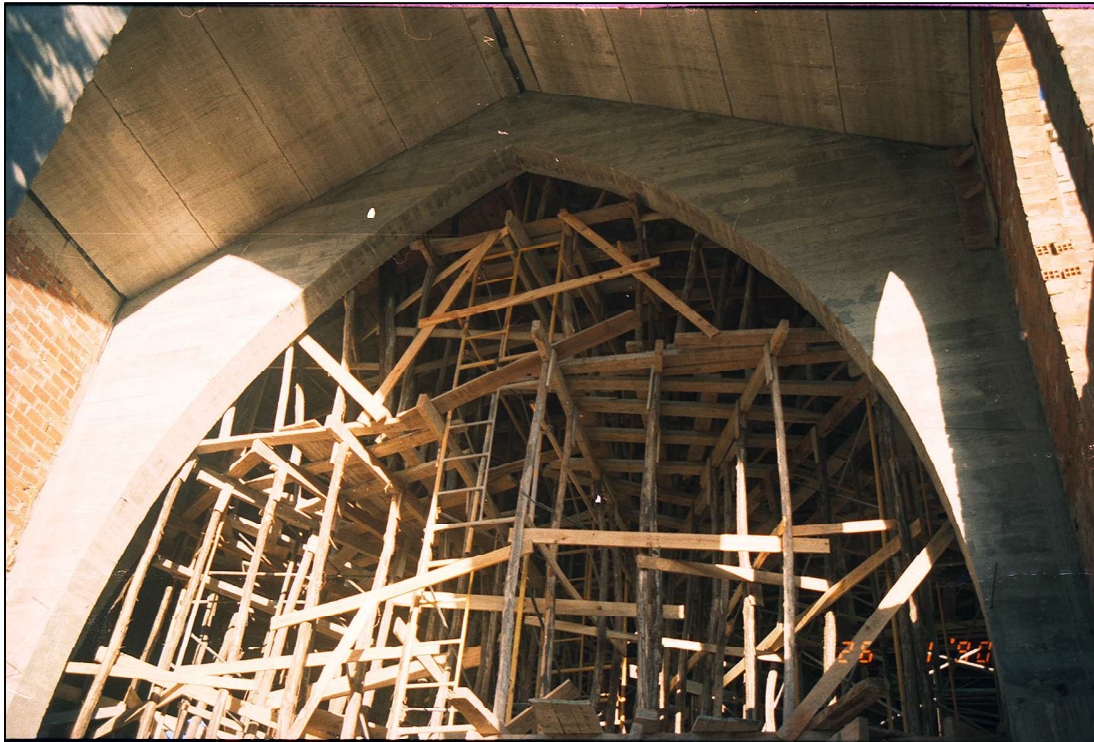
ENERO DE 1990- EL COMPLICADO ENCOFRADO DE LA CUBIERTA
