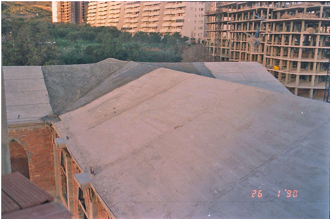
ENERO DE 1990- LA CUBIERTA DEL TEMPLO TOMA CUERPO
